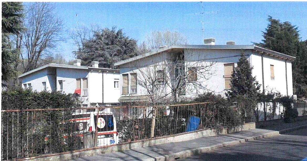
Case prefabbricate su via F. Goya dell'arch. P. Bottoni
